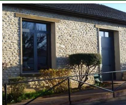
Changement des fenêtres et portes Salle des Fêtes / Mairie
