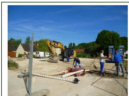
Préparation du terrain
