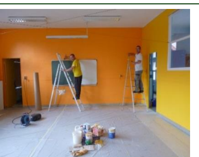
Peinture d'une classe rénovée
