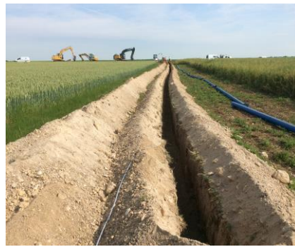
Des longueurs de tranchées pour les conduites de l'eau sont nécessaires
