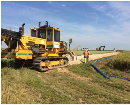
Interconnexion Eau Début du chantier
