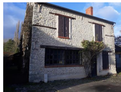
Dernière acquisition pour y installer un commerce : l'ex « maison Charpentier »
