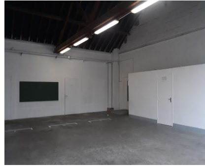
Rénovation du préau intérieur de l'école élémentaire
