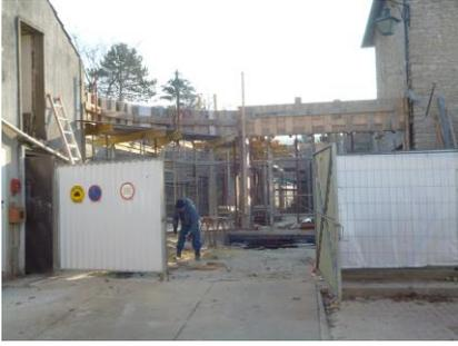
Les travaux se poursuivent, un peu freinés par la baisse brutale des températures. Dès la remontée du thermomètre, le coulage du béton pour l'étage à l'intérieur sera effectué et les poutres de la plateforme de l'extension mises en place. Nous nous excusons pour la gêne à la circulation rue de la Mairie et nous nous efforcerons de respecter les délais prévus.
