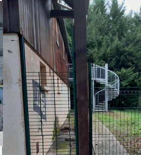
Réparation des grilles au gymnase
